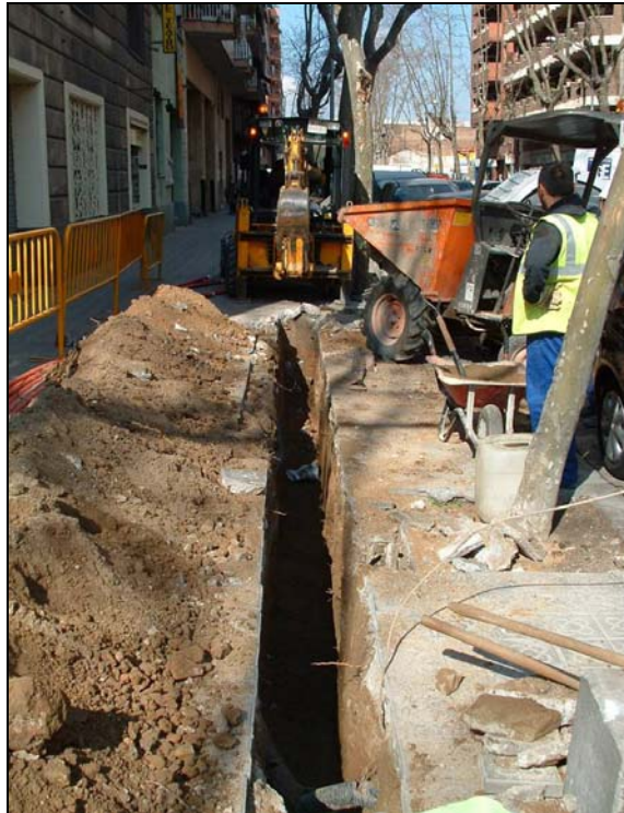
Fotografia 32. R/4 un cop realitzat el buidatge de terres.
