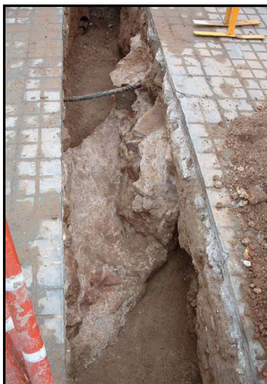
Fotografia 15. Detall mur UE 111.
