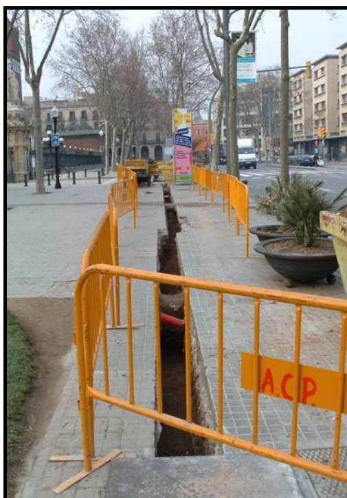
Fotografia 21. Vista general tram R/1-2, un cop realitzat el buidatge de terres de 90 cms. Direcció Passeig Picasso.
