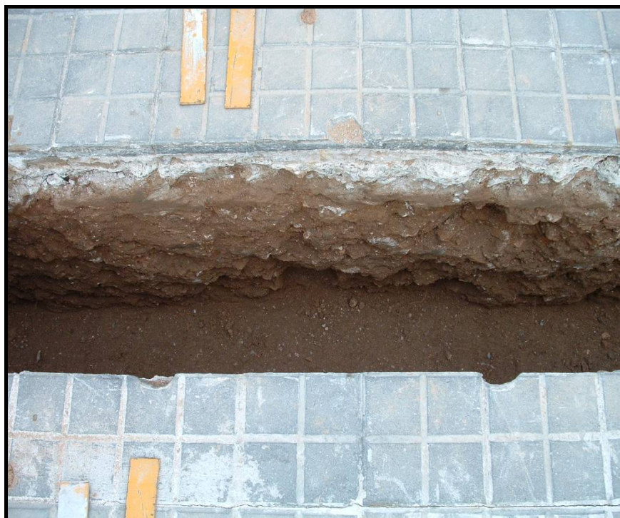
Fotografia 11. Detall secció R1/1 realitzada al Passeig Pujades, després del buidatge de terres a 90 cm. A la fotografia es pot apreciar la seqüència estratigràfica.
