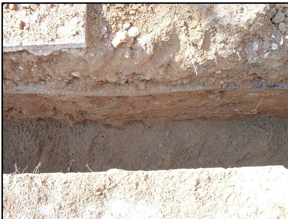
Fotografia 35. Detall en secció de R/4. S'observa el rebliment de sauló i els serveis localitzats.
