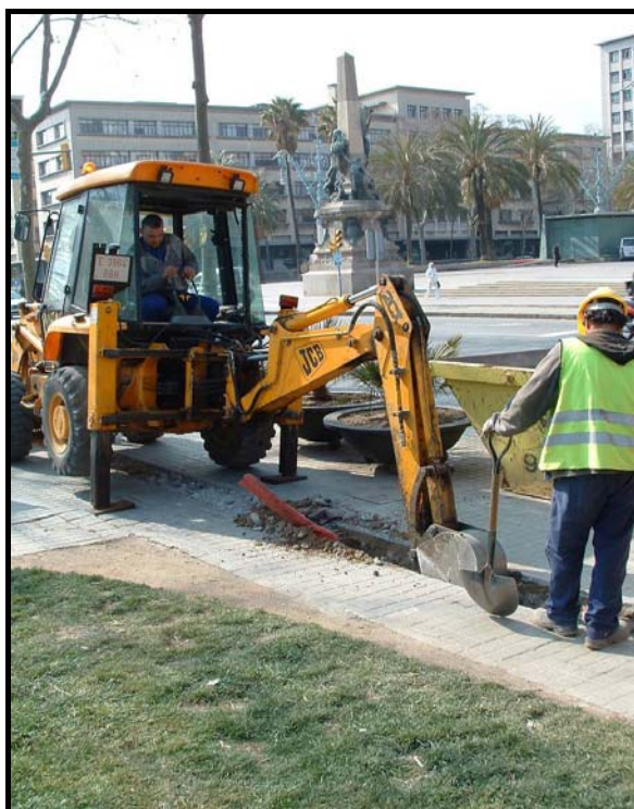
Fotografia 6. Detall màquina retroexcavadora realitzant les tasques de buidatge de terres a R1/2 direcció Passeig Picasso.
