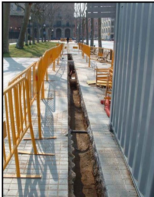
Fotografia 22. Vista general tram R/1-2, un cop realitzat el buidatge de terres de 90 cms. Direcció Passeig Picasso.
