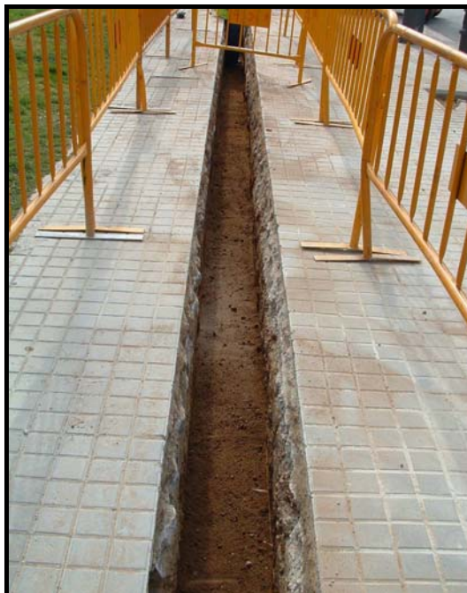
Fotografia 24. Detall tram R/1-2, un .cop realitzat el buidatge de terres de 90 cms. Direcció Passeig Picasso.
