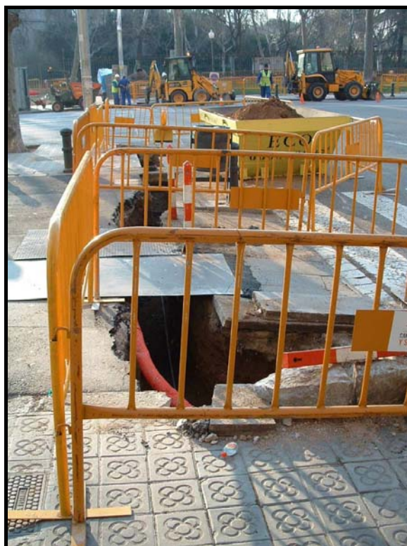
Fotografia 31. R/3 un cop realitzat el buidatge de terres.
