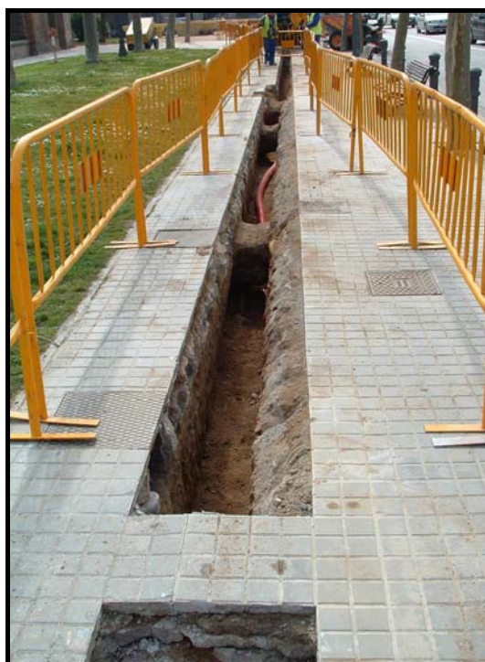
Fotografia 23. Detall tram R/1-2, un cop realitzat el buidatge de terres de 90 cms Direcció Passeig Picasso.
