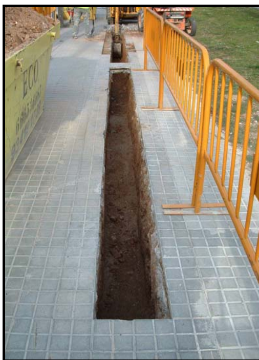
Fotografia 9. Detall tram R1/1-, un cop realitzat el buidatge de terres de 90 cm.
