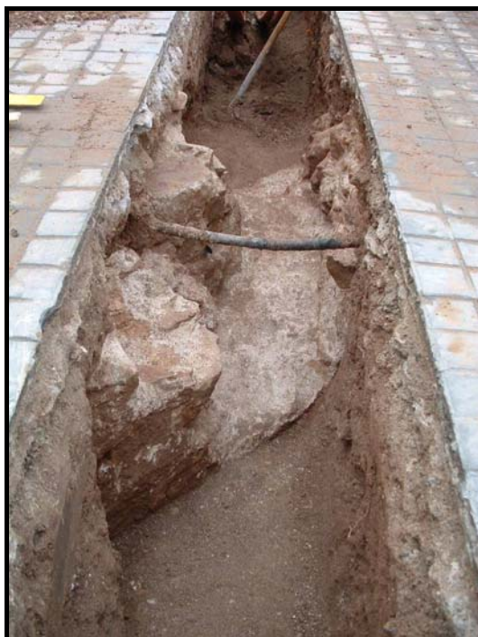
Fotografia 16. Detall mur UE111.
