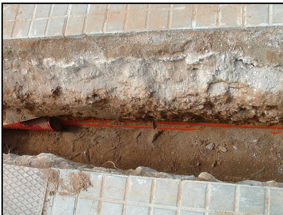
Fotografia 25. Detall en secció del servei de la llum localitzat al tram R/1-2.
