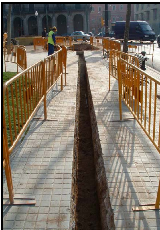
Fotografia 26. Detall tram R/1-2, un cop realitzat el buidatge de terres de 90 cms. Direcció Passeig Picasso.
