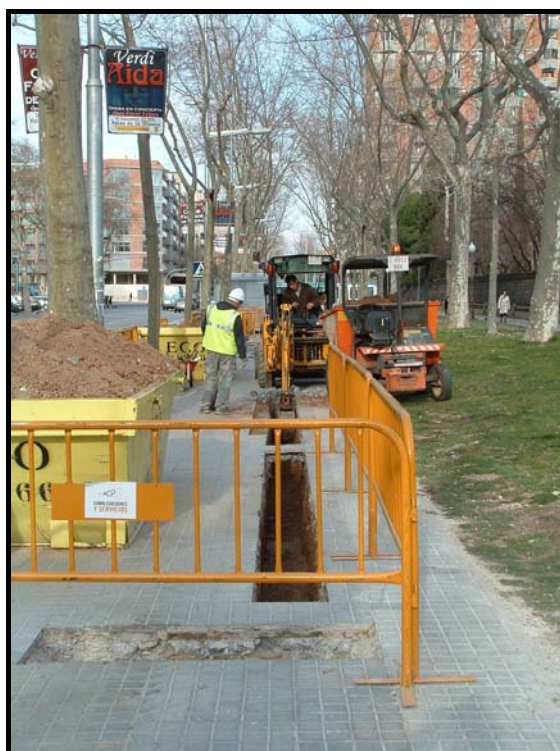
Fotografia 5. Detall màquina retroexcavadora realitzant les tasques de buidatge de terres a R1/1, direcció Meridiana.
