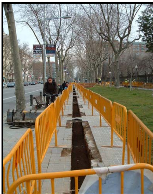
Fotografia 8. Vista general R1/1, direcció Avda. Meridiana, un cop realitzat el buidatge de terres de 90 cm.
