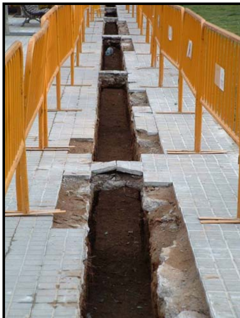
Fotografia 10. Detall tram R1/1, un cop realitzat el buidatge de terres de 90 cm.
