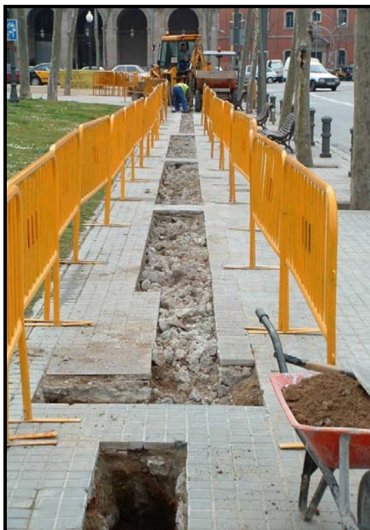
Fotografia 4. Detall treballs obertura R1/2. Demolició del paviment amb la màquina retroexcavadora.
