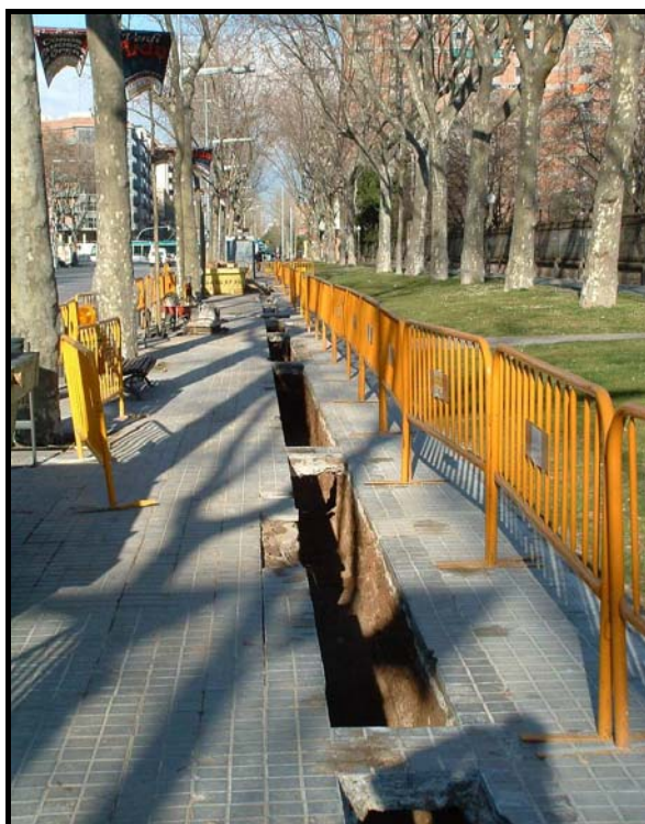
Fotografia 7. Vista general R1/1, direcció Avda. Meridiana, un cop realitzat el buidatge de terres de 90 cm .
